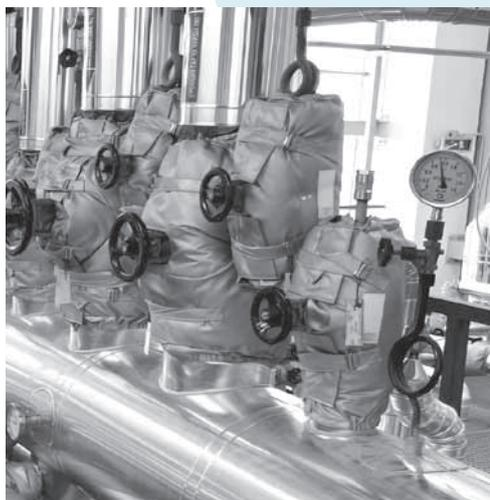
**Термочехол – быстроремонтируемая гибкая многоразовая теплоизоляционная конструкция.** Это лучшее решение для теплоизоляции оборудования, к которому требуется регулярный доступ с целью контроля и обслуживания.
