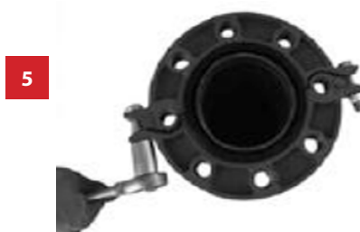
Затянуть гайки
