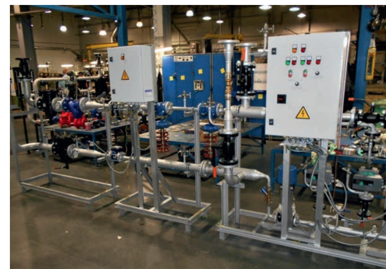
Гранбтп после сборки на производственном комплексе АДЛ в п. Радужный
