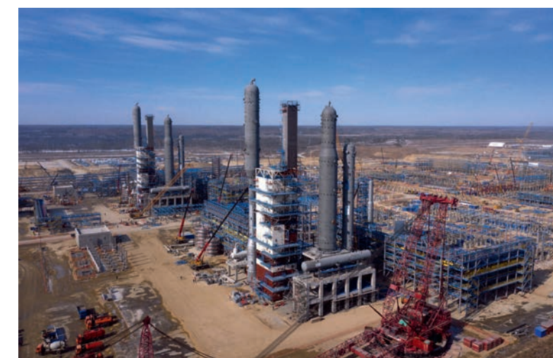
Строительство Амурского ГПЗ
