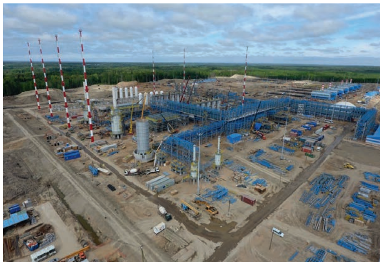
▲ Строительство компрессорной станции Славянская
