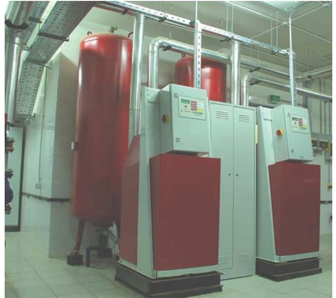
ние. Система отопления высотного корпуса поделена на три зоны. Общая расчетная тепловая мощность системы отопления — 4,25 Гкал/ч.
